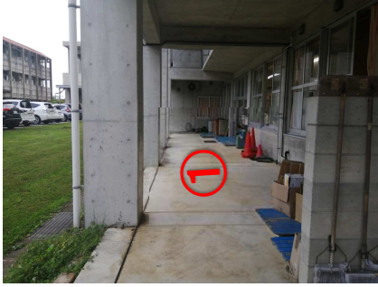
① 駐車場側の職員室前
